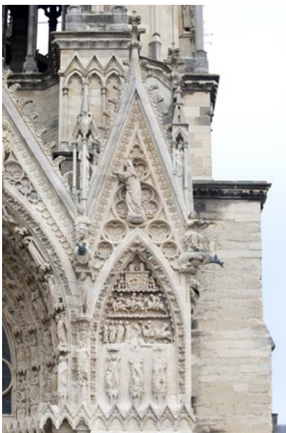
Contrefort sud de la façade occidentale avec des scènes de l'Apocalypse
