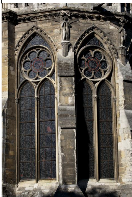
Fenêtre châssis rémoise (chevet)
