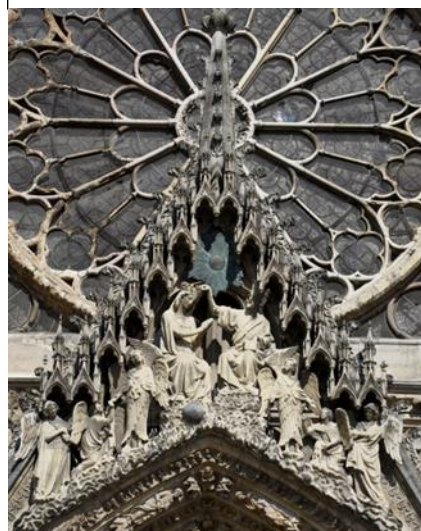
Gâble central : couronnement de la Vierge
