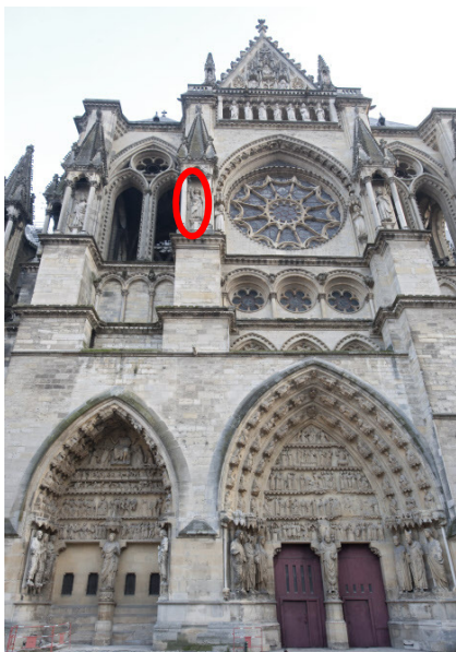
Localisation sur la façade du transept nord
