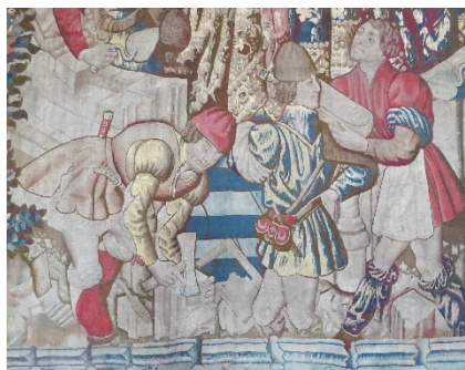
Un chantier dans la tapisserie de l'Histoire de Clovis au XVe siècle (palais du Tau)
