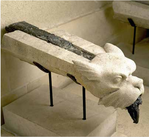
Gargouille déposée de la cathédrale de Reims avec leur langue de plomb solidifiée à la suite de l'incendie du 19 septembre 1914
