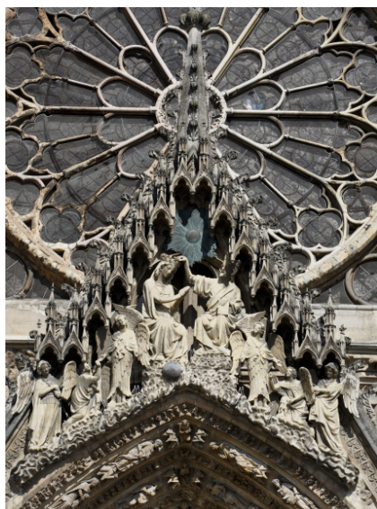
Localisation sur la façade occidentale
