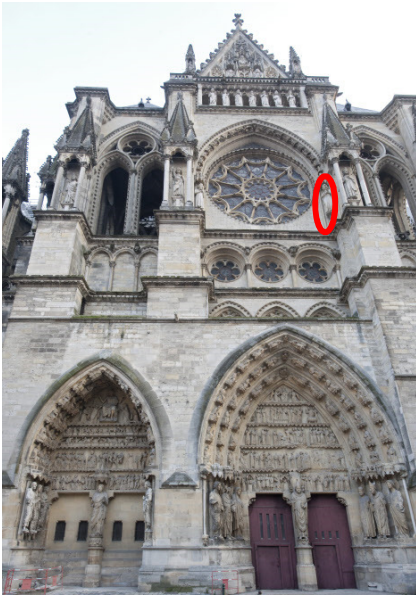
Localisation d'Eve sur la façade du transept nord
