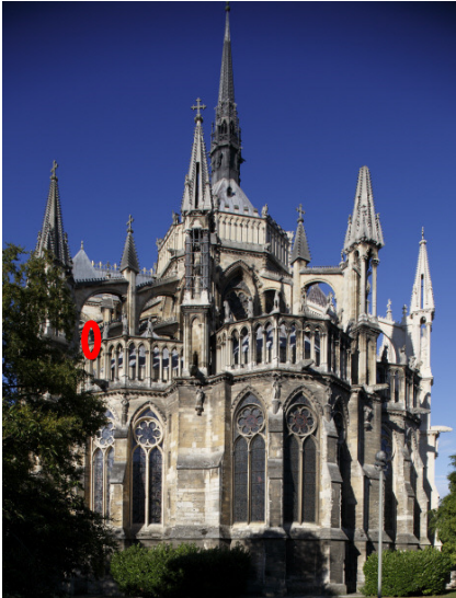
Localisation sur la balustrade du chevet
