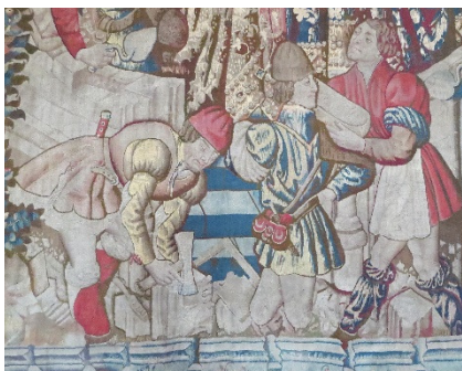
Un chantier dans la tapisserie de l'Histoire de Clovis au XVe siècle (palais du Tau)
